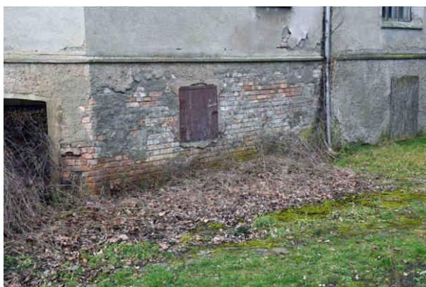
Ansicht des verputzten Kellermauerwerks aus Klinkermauerwerk an der Straßenseite; Es sind keine Setzungen oder Verformungen erkennbar. Aufnahme Verfasser, 04.03.2019
