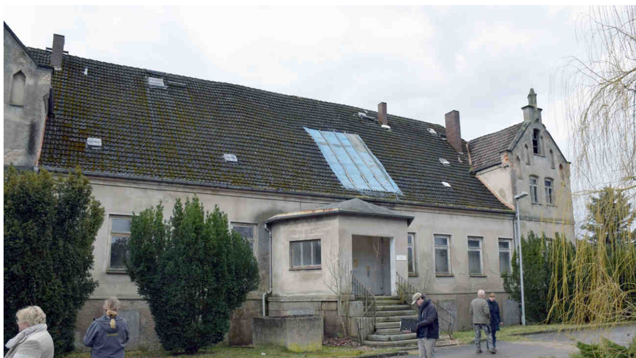
Ansicht von der Straßenseite, Aufnahme Verfasser, 04.03.2019
