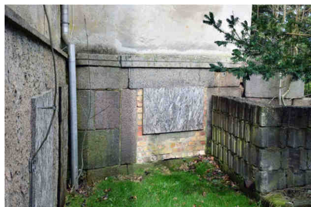
Ansicht des Kellermauerwerks des Mittelrisalits aus Klinkermauerwerk an der Straßenseite, das mit Granitplatten verkleidet ist; Es sind keine Setzungen oder Verformungen erkennbar. Aufnahme Verfasser, 04.03.2019
