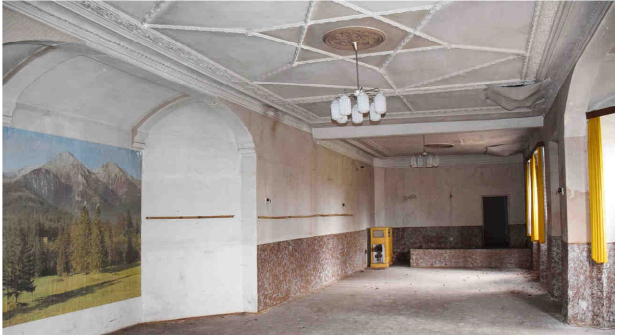
Ansicht von der Parkseite, Aufnahme Verfasser, 04.03.2019
